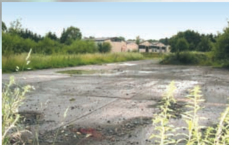
Betonplatte der früheren Kunststoffspritzerei
