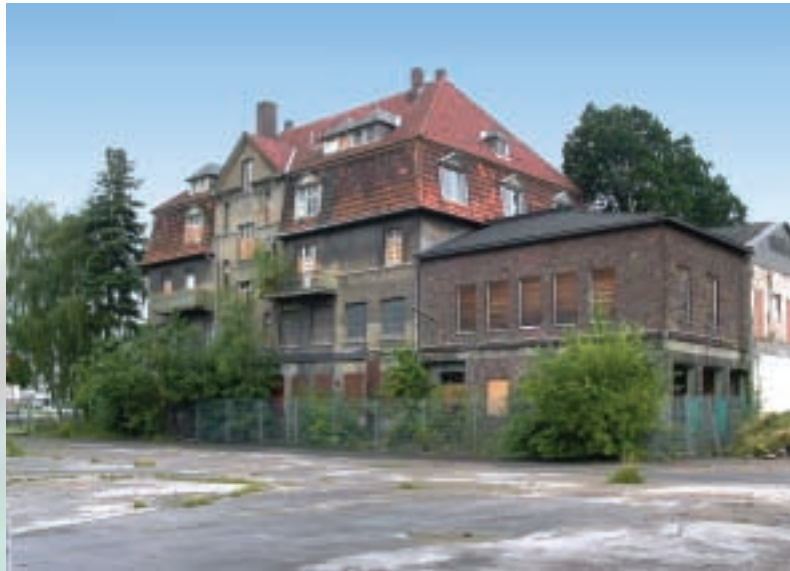
Rückwärtige Ansicht der ehemaligen Fabrikantenvilla
