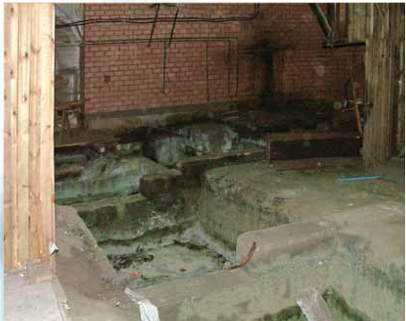
Innenansicht der ehemaligen Imprägnier-/Sägehalle
