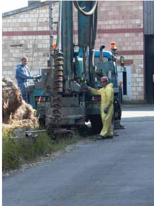
Errichtung von Grundwassermessstellen auf dem Gelände
