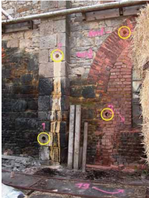
Baustoff- beprobung durch Bohrkern- entnahme
